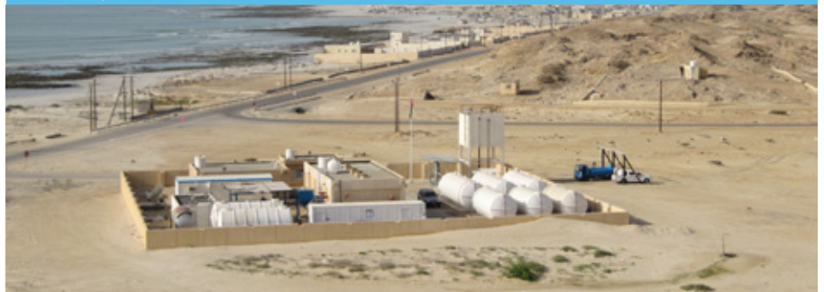
MOD PLANT, AL KHALUF AUG 2010
